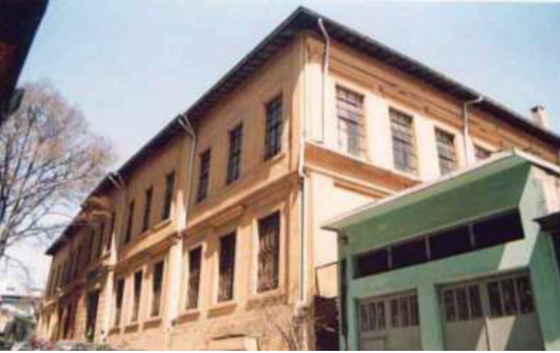
Resim 22- Türbe/Valide Mektebi Sokağı'ndan Mekteb-i Mülkiye-i Şahane'ye tahsis edilen Valide Mektebi / Darülmâarif Binası'nın görünümü (günümüzde Çağaloğlu Anadolu Lisesi kullanımdadır).
